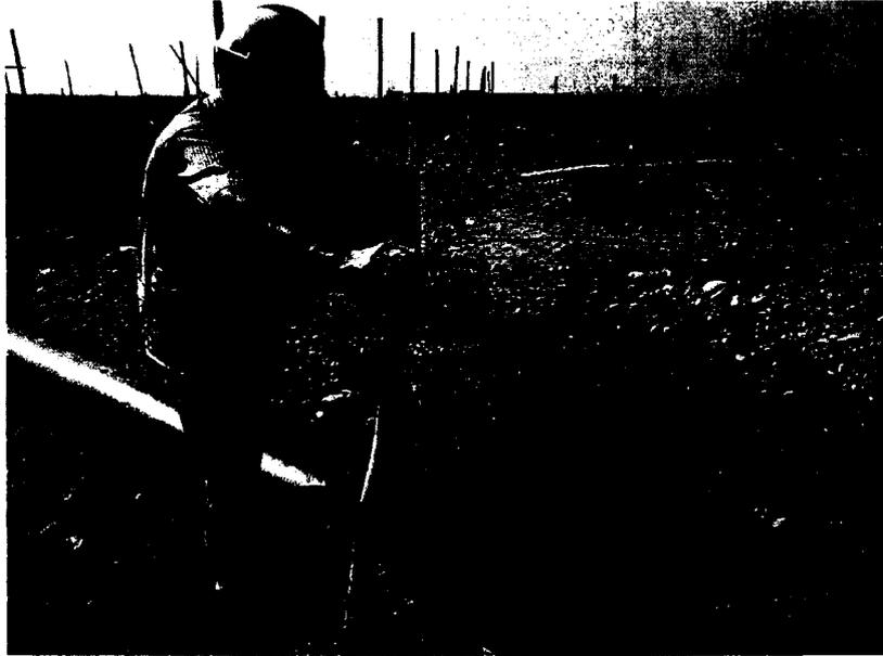
FOTO 03: Supervisor verificando profundidad de excavación de cimentación de poste de concreto
